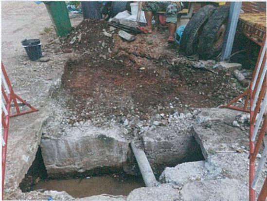
ภาพถ่ายขณะดำเนินการ และหลังดำเนินการปรับปรุงและซ่อมแซมฝารางระบายน้ำ ถนนเทศบาล ๘ ตามข้อร้องเรียน/ร้องทุกข์
